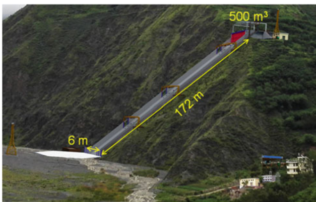
Fig. 24 Schematic of 172 m-long flume (Kunming, China)
